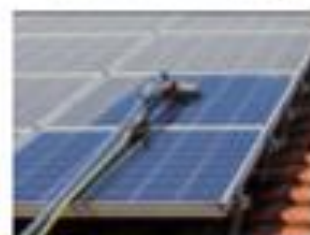
Zonnepaneel reiniging
